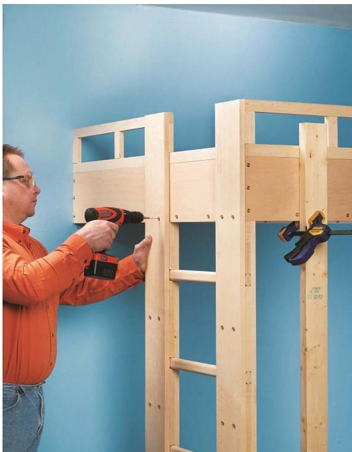
Placez l'échelle à l'angle des bords latéraux avant et gauche. La couche d'échelons et la couche de patte courte doivent être bien ajustées sous la boîte, car l'échelle servira de poteau de coin. Fixez l'échelle à la boîte de matelas.
