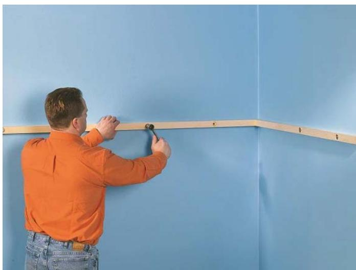
Pré-assemblez les taquets de mur en forme de L et fixez-les aux montants de mur avec des tire-fonds et de l'adhésif.
