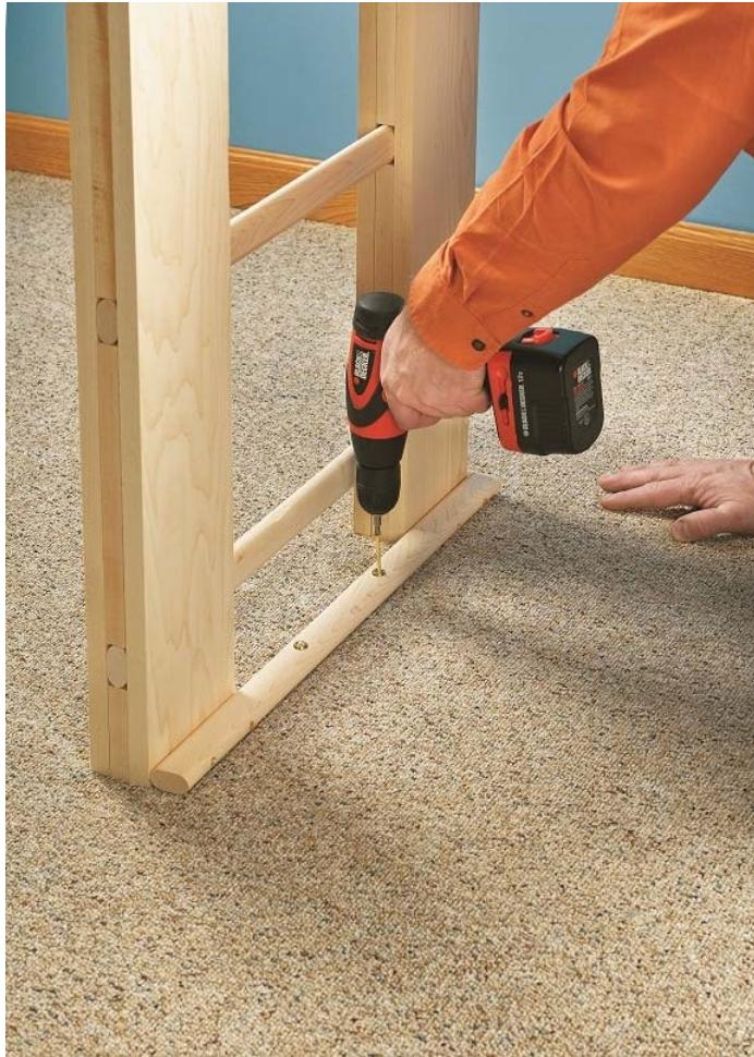
Fixez le bas de l'échelle/poteau d'angle en fixant un taquet au sol derrière les pieds de l'échelle.
